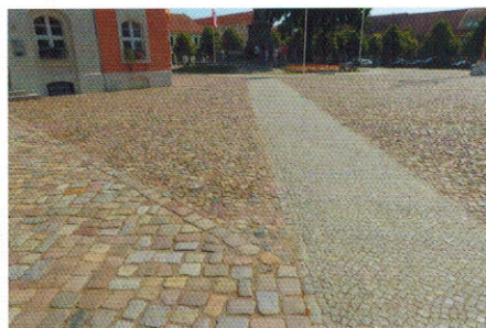
Marktplatz am Rathaus in Templin: Wege- und Platzbefestigung mit Lesesteinen, Großpflaster und Kleinpflaster.
