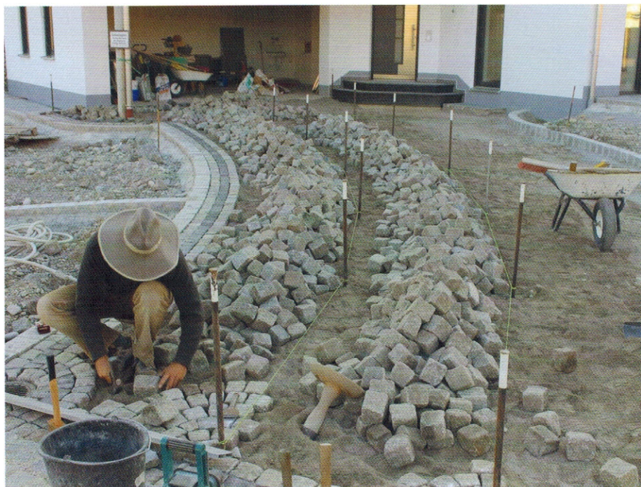
Steinsetzer in Aktion: Frank Schnitzler pflastert eine Zufahrt. | Fotos: Netzwerk Pflasterbau
