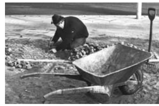
Bürgersteig wird gepflastert [Quelle: Historisches Archiv der Stiftung Deutsches Technikmuseum Berlin]
