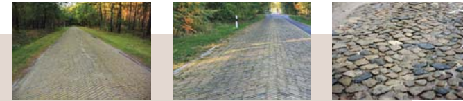
K6942 Ziegelsteinpflaster zwischen Riewend und Bagow Ziegelsteinpflaster bei Klein Behnitz ehemalige Landstraße mit Polygonpflaster bei Annenwalde
