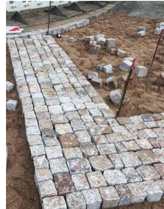
Diagonalpflaster in einer gekrümmten Straße. Auch für Beißner war die Einfahrt in die Altstadt von Lemgo eine Herausforderung.
