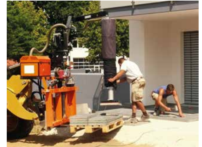
Einführung der Vakuumtechnik im Bauwesen im Jahr 1991
