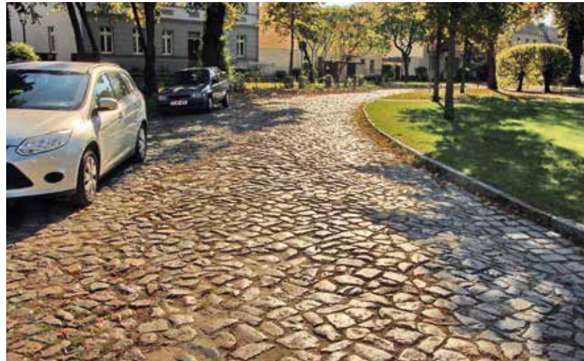
altes Pflaster aus Lesesteinen, Potsdam
