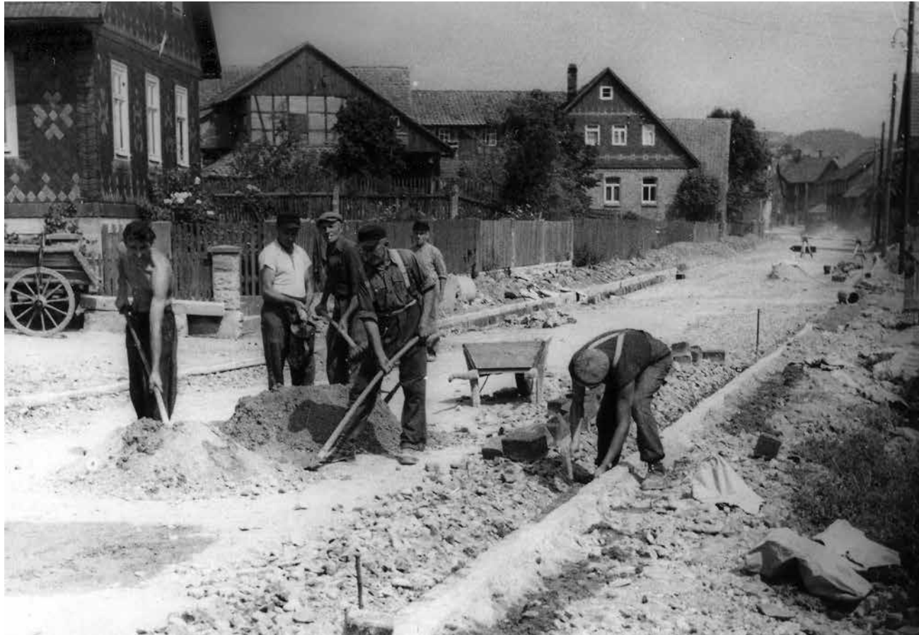
Straßenbau in den 50er Jahren: Das Setzen der Bordanlage war Schwerstarbeit (Quelle: Optimas)
