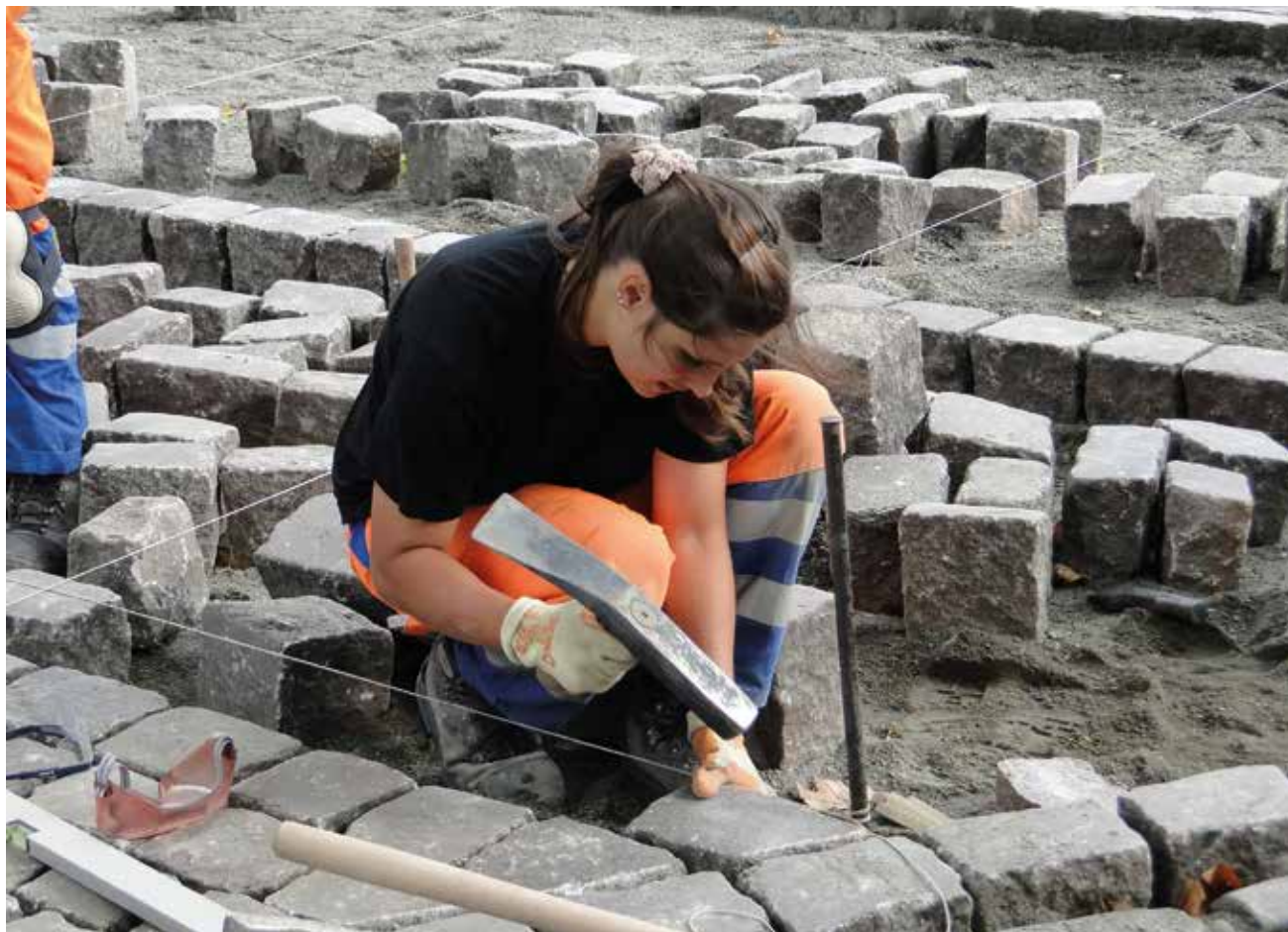
Auszubildende beim Verlegen von Großpflastersteinen, Goodwill-Aktion des Berufsförderungswerks Brandenburg
