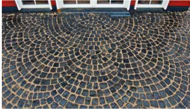
Basaltkleinpflaster, Halbrosette als Eingangsportal vor einem Gartenhaus, 2009 in Ortenberg (Region: Wetterau)
