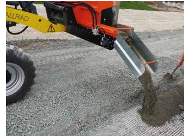
seitliche Entleerung d. Schaufel über ein Förderband; exakte Dosierung d. Materialmenge durch Förderband- und Fahrgeschwindigkeit
