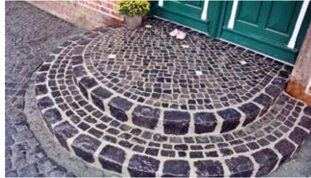
Eingangspodest aus Mosaikpflaster in Passe gesetzt, Stufenumrandung aus Basalt-Großpflaster, Wetter in Nordhessen
