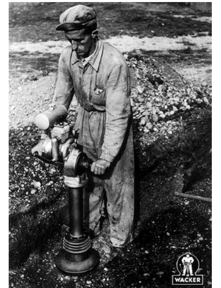
1. Generation der Vibrationsstampfer in den 1930ern (Quelle: Wacker Neuson)
