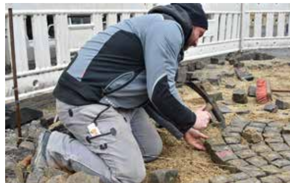
Beißner beim Versetzen von Segmentbogenpflaster – fachgerecht von der Mitte des Feldes nach außen zur Schnur (Foto: Tjards Wendebourg)
