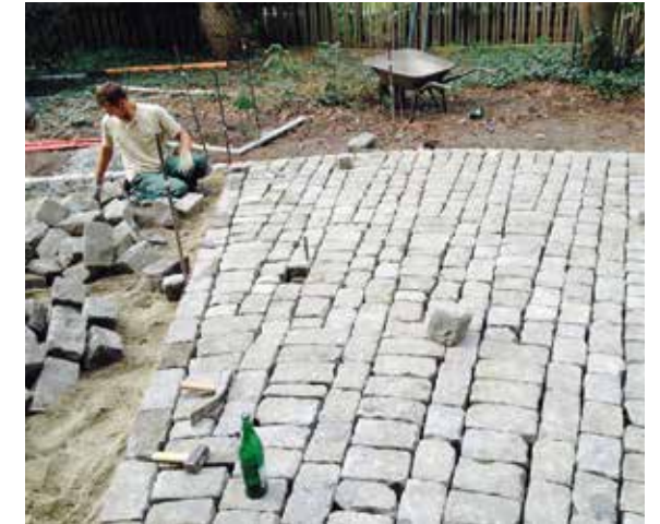
Elegant gelöst: ganz schön kann man die Technik sehen, wie mit Reihenpflaster eine Kurve hergestellt wird.
