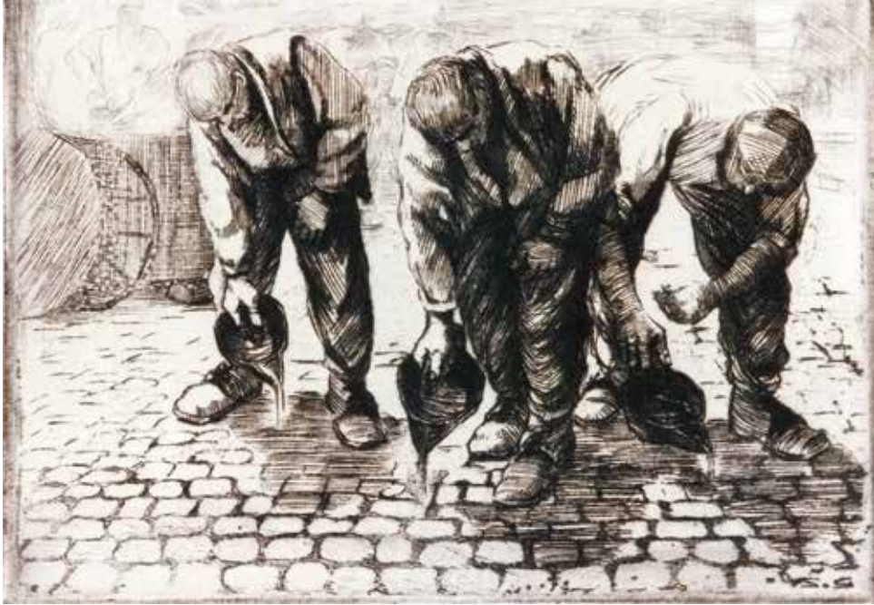
Straßenarbeiter in Großstadt: Vergießen von Pflasterfugen mit Teer um 1900 [Quelle: Historisches Archiv der Stiftung Deutsches Technikmuseum Berlin]
