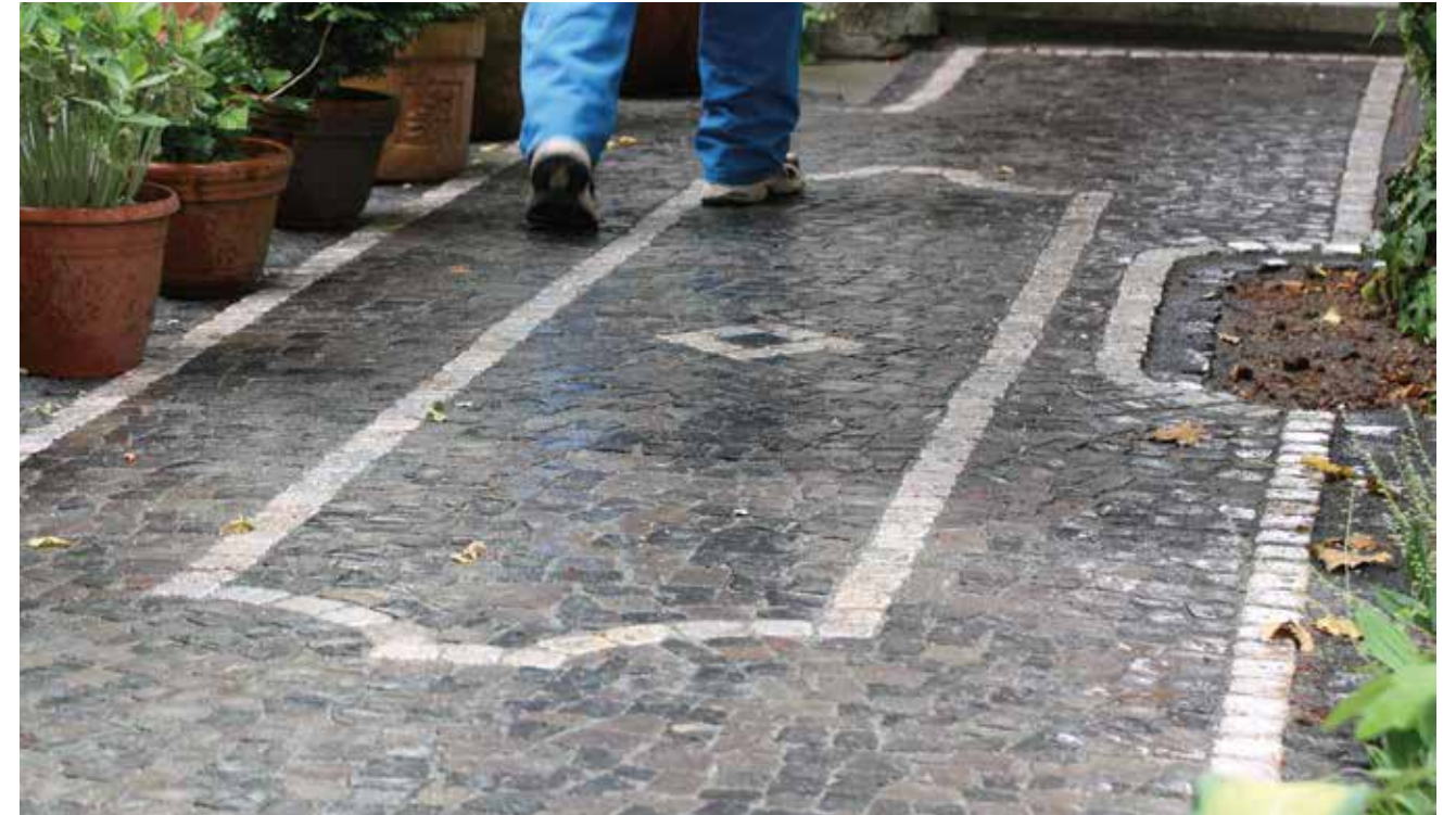
historische Rekonstruktion einer Jugendstil-Pflasterung – 100 Jahre altes Basaltmosaik wieder in Form gebracht, Dreieich bei Offenbach
