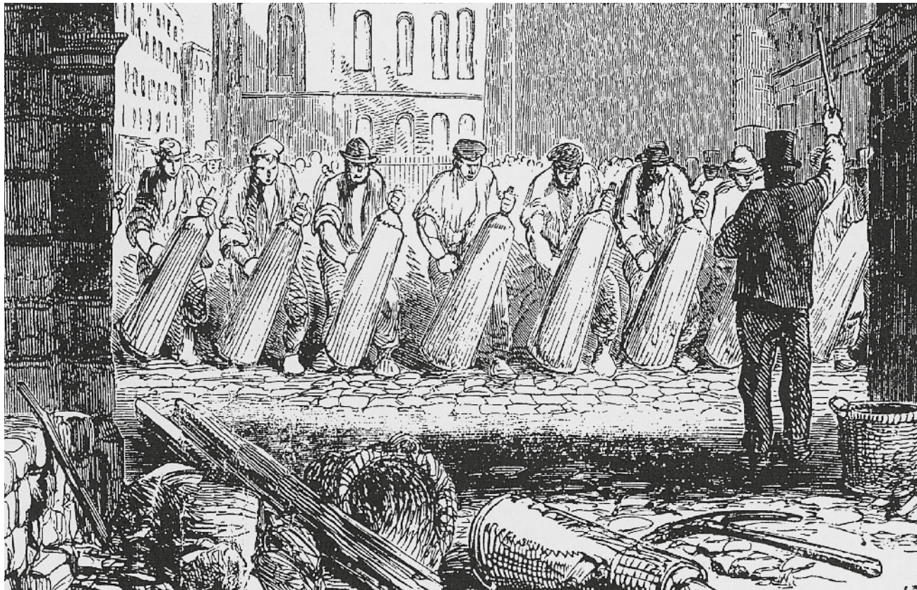
Verdichtung von Unterbau und Pflasterflächen im letzten Jahrhundert: Der Stößel musste den Stein gleichmäßig und regelmäßig treffen, d.h. mit der gleichen Kraft und der gleichen Anzahl an Stößen. [Quelle: Howcroft 2015]
