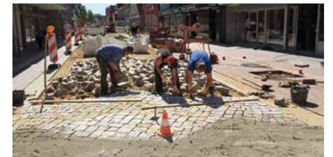
Auf der „Alten Straße“ wurde das Granitgroßsteinpflaster in Sandbettung versetzt. (Foto: Lothar Steffen SSR)
