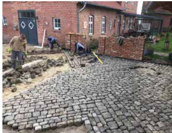
M-Strich Verband Großpflaster Baustelle bei Neustadt am Rübenberge
