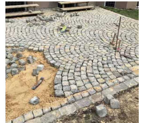
Aus der Ecke heraus entwickelt sich dieses Segmentbogenpflaster...auf einer Terrasse in Bielefeld. Auch hier hat Beißner auf gewaschenem Sand versetzt.
