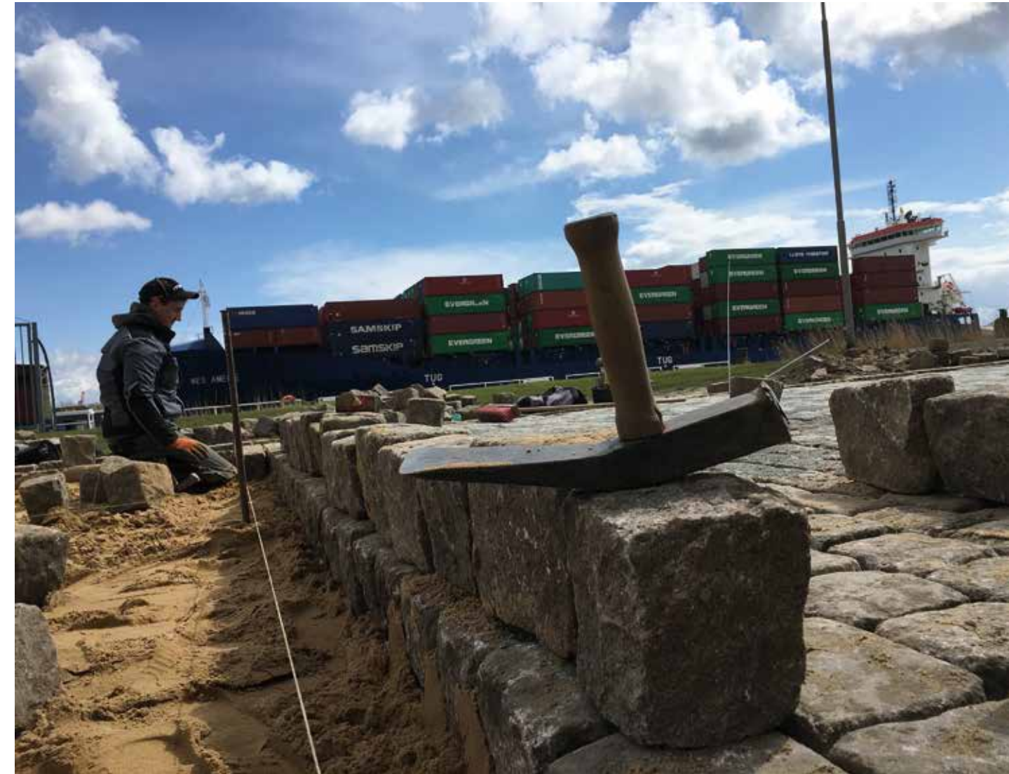
Als Subunternehmer für einen GaLaBau-Betrieb hat die Firma den Belag einer historischen Schiffstankstelle im Hafen Brunsbüttel rekonstruiert. Dabei galt es Großpflaster fachgerecht zu versetzen.
