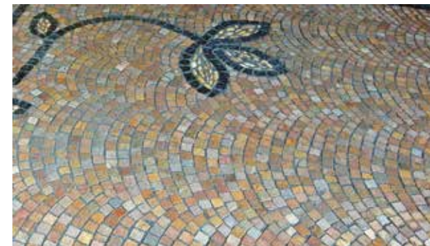
Gestaltung einer Terrasse mit Sandsteinpflaster 4/6, verziert mit Kieselsteinblüten, September 2010 in Braunfels
