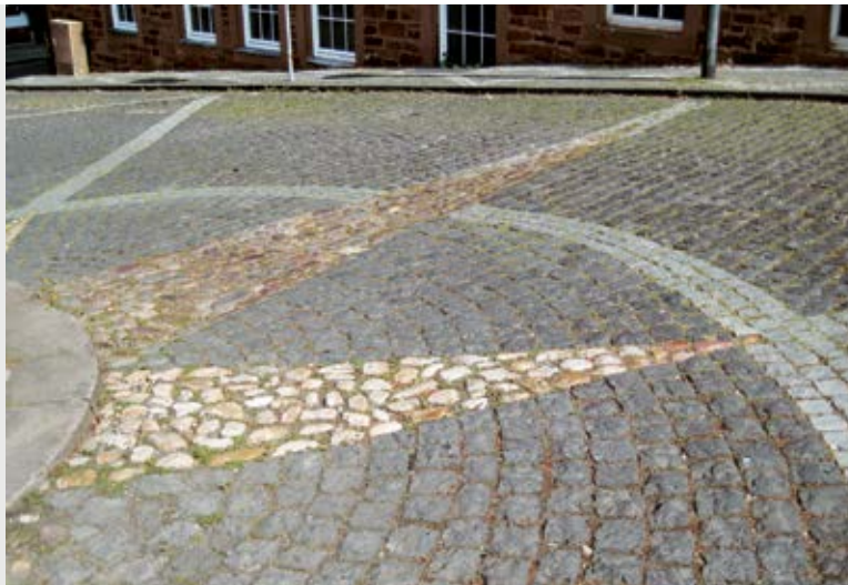
Pflasterfläche am Rathaus Nideggen. Eine Kombination aus Basaltlava, Basalt, Granit und Rurkieseln (je nach Gegend auch als Katzenköpfe bezeichnet). Liegt seit 60 Jahren; Schäden entstehen in der Regel nur nach/durch Eingriffe. Lage und Untergrund stabil. Harmonische Verlegung; handwerklich gutes Fugenbild.
