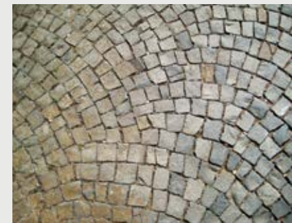
Klassische Verlegung von Bögen im Stadtkern Nideggen. Nur in enger, sauberer Verlegung kommt Stabilität in das Gefüge. Außerdem entsteht ein handwerklich hochwertiges Pflaster – und Fugenbild.
