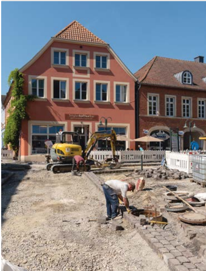
In Telgte werden die ursprünglichen Platten des Belages glattgesägt und wieder eingesetzt, um zukünftig besser begeh- und berollbar zu sein.
