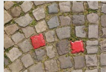
In Telgte werden die ursprünglichen Platten des Belages glattgesägt und wieder eingesetzt, um zukünftig besser begeh- und berollbar zu sein.
