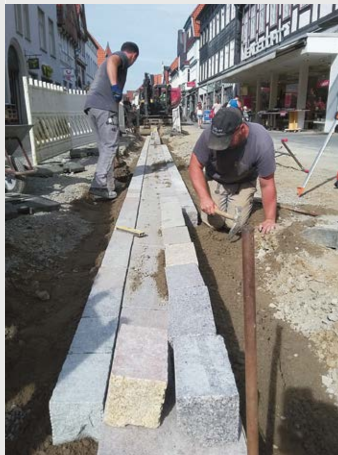
Lemgo bekommt seit 2016 eine „neue Mitte“, damit die Einkaufsmeile besser begehbar wird. Die Pflasterarbeiten in der Mittelstraße begannen mit der Mittelrinne.
