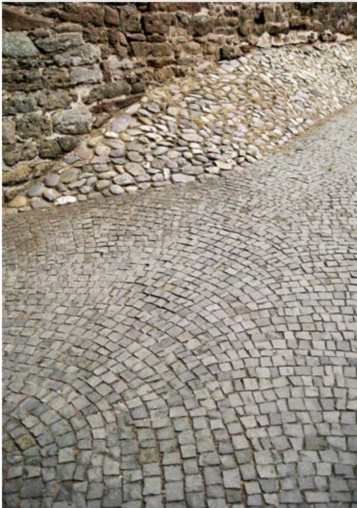
Schöne Kombination zwischen Kleinpflaster, Rurkieseln und Bruchstein in einer Nebenanlage in Nideggen
